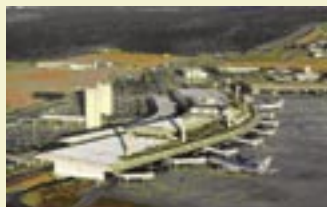
Recuperação de Cascalheira do Aeroporto Internacional de Brasília Recovery of gravel degradation at Brasília International Airport
