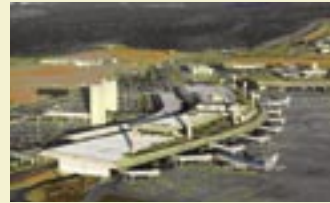
Aeroporto de Confins Confins Airport
