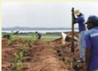
Recuperação de área degradada no Aeroporto Internacional do Galeão Recovery of degraded area at Rio de Janeiro Galeão Airport
